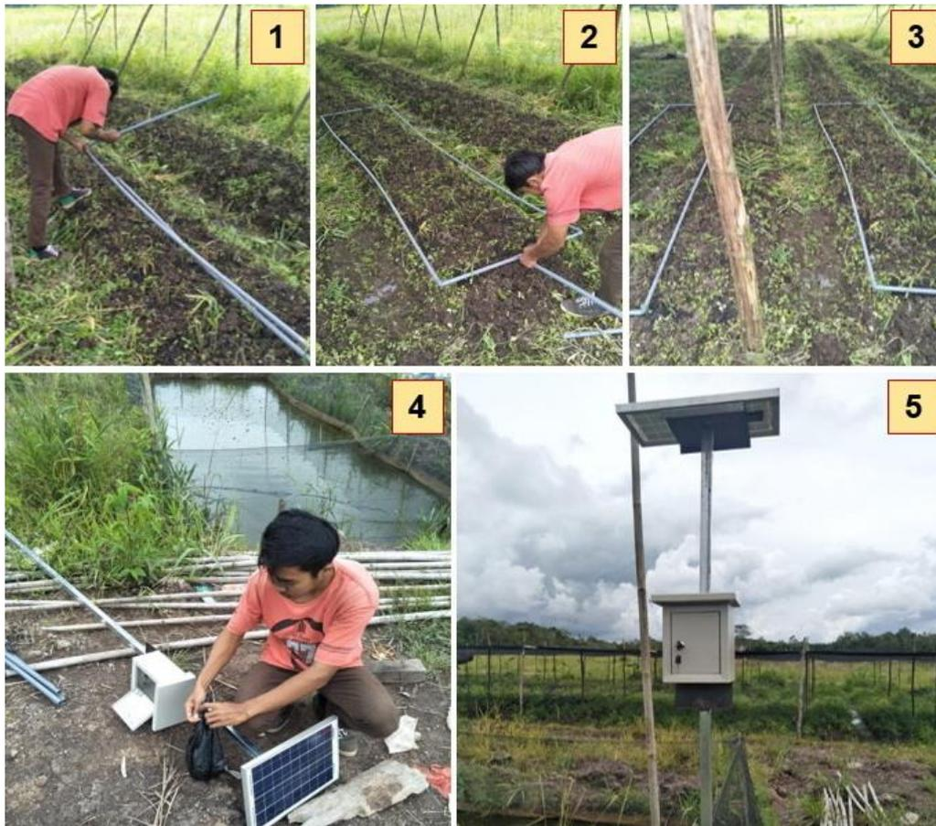
Gambar 5. Tahapan Pemasangan Sistem Irigasi dan Pemupukan Otomatis Di Lapangan
