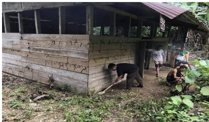
Gambar 4. Persiapan Lokasi Pembibitan
