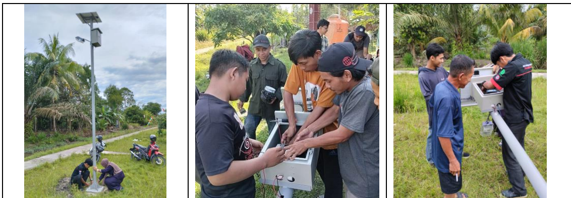
Gambar 7. Perawatan dan perbaikan PJU TS nomor 2
